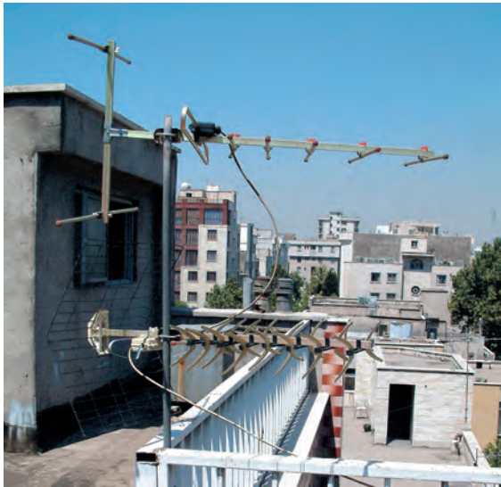
شکل ۶۹-۱- آنتن VHF و UHF روی دکل
