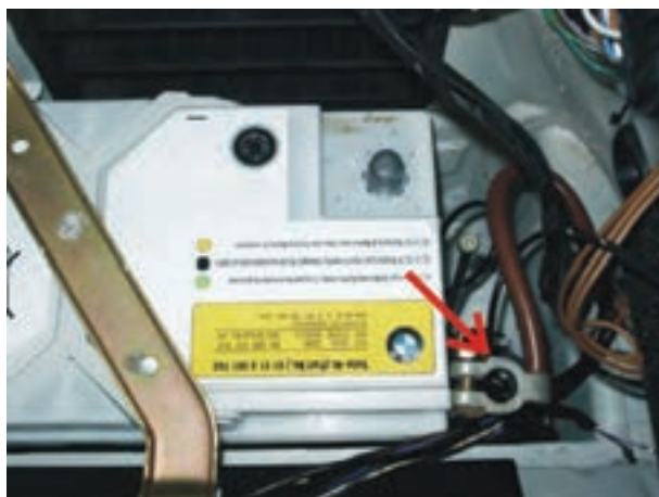
شکل ۳۵-۱- جدا کردن بست اتصال کابل بدنه‌ی باتری
