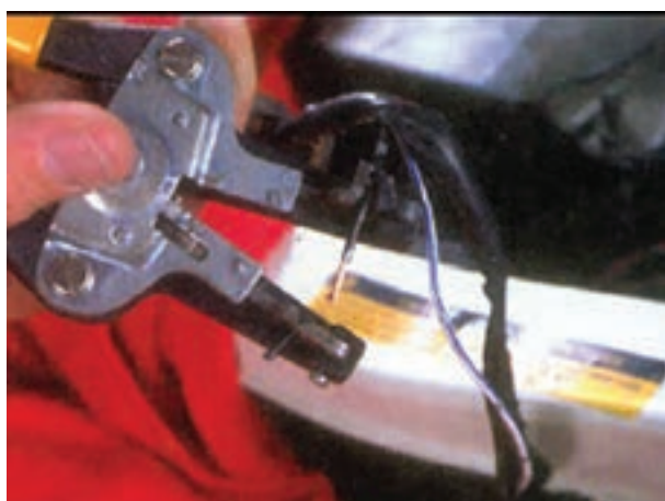
شکل ۱۴۷-۱- استفاده از ابزار سیم لخت کن
