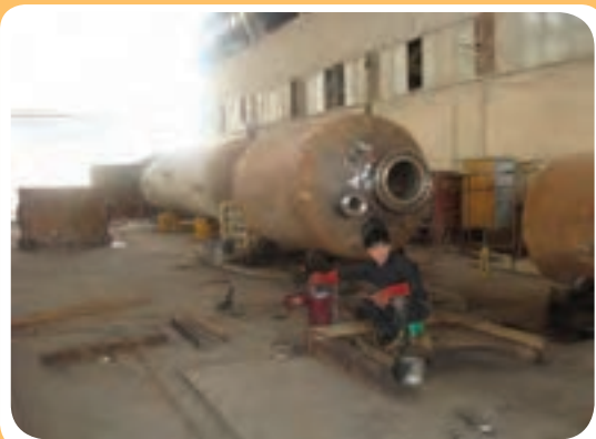
ب) کارگاه ساخت مخازن تحت فشار
