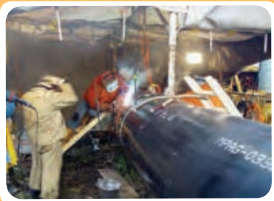
ن) کارگاه ساخت خط لوله
