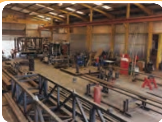
الف) کارگاه ساخت سازه‌های ساختمانی
