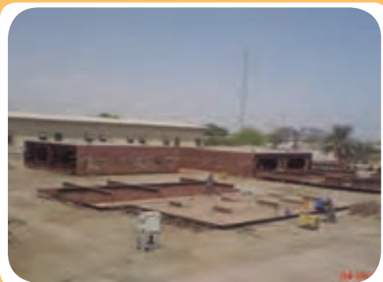
د) کارگاه ساخت اسکلت فلزی ساختمان
