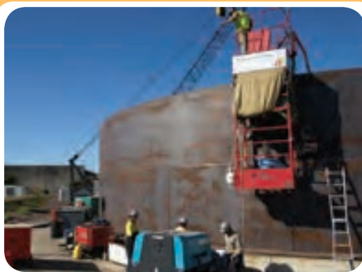
م) کارگاه ساخت مخازن ذخیره
