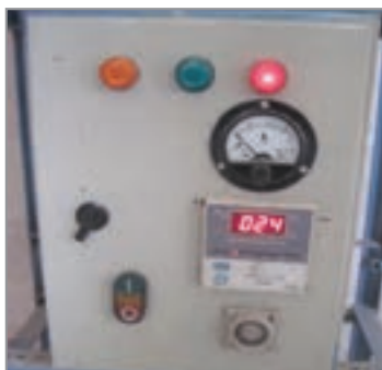
شکل ۳۵- اندازه‌گیری دمای کوره
