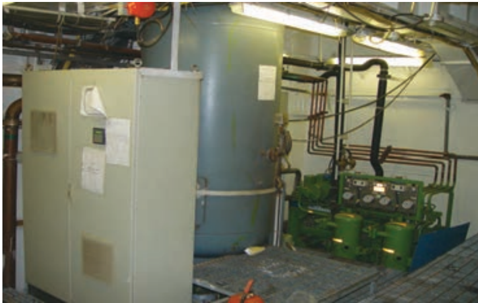
شکل ۱۷- سامانه هوای فشرده
