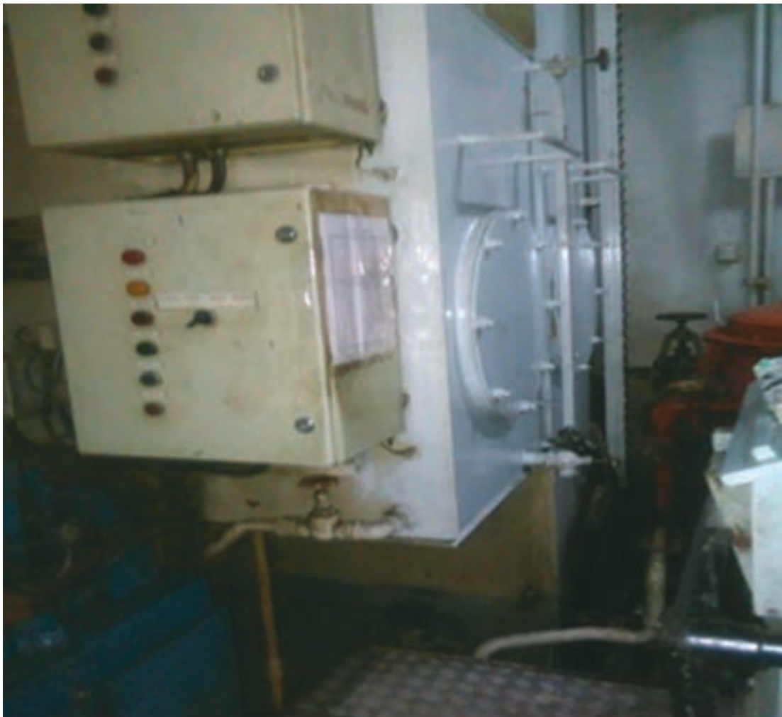
شکل ۲۳- مخزن سوخت روزانه یک شناور
