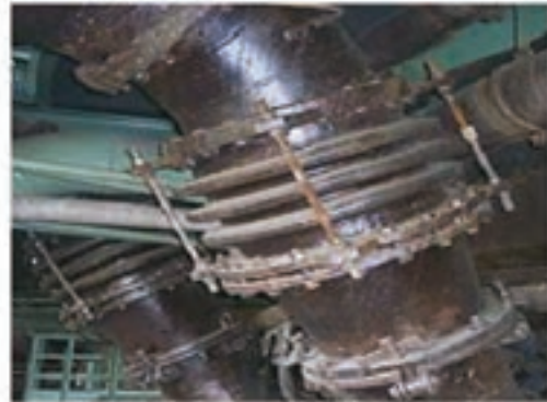
شکل ۴۳- اتصال‌های قابل انبساط
