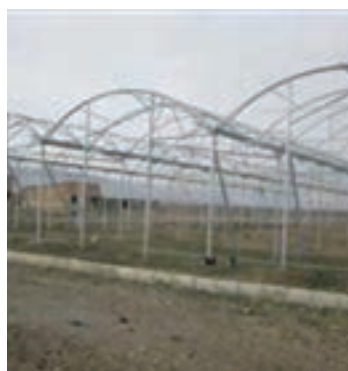
اسکلت گلخانه به سبک تونل - پیوسته
