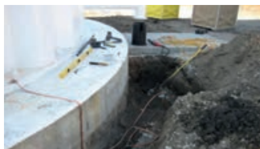
شکل ۴-۲۵- تخلیه الکتریسیته ساکن بدنه مخزن به زمین
