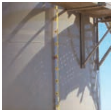
شکل ۲۲-۴- ارتفاع سنج مغناطیسی روی مخزن
