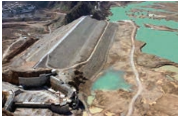
شکل ۱-۲۵- احداث سد سیوند بر روی رود سیوند
