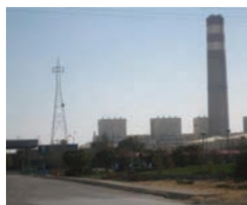
شکل ۱۹-۵- نیروگاه برق شهید مفتاح - فامنین
