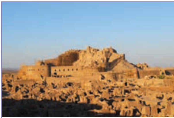
شکل ۳۱- ۵- ارگ بم در حال بازسازی
