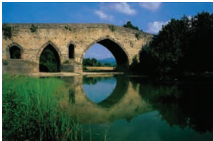
شکل ۲-۵- پل شاهپور در شیرگاه
