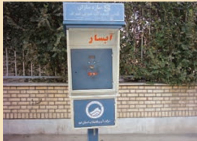
شکل ۷-۶- تصویر یکی از ایستگاه‌های توزیع آب شیرین (آبسار) در شهر قم
