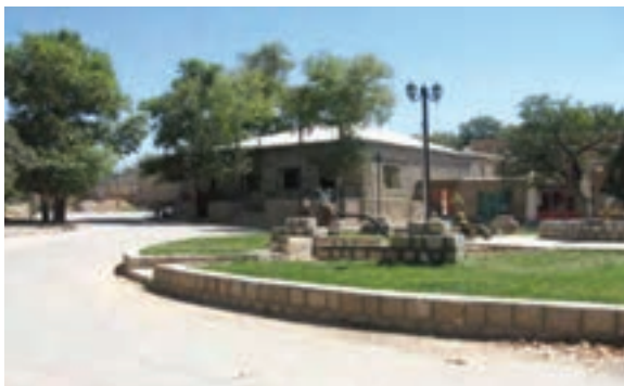
شکل ۲۳-۲- اجرای طرح هادی روستای بدرانلو بجنورد
