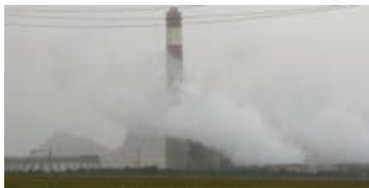
شکل ۴۸-۱- آلاینده‌های نیروگاه حرارتی
