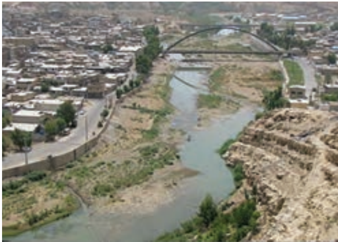
شکل ۷-۵ - خرم‌رود در فصل کم آبی
