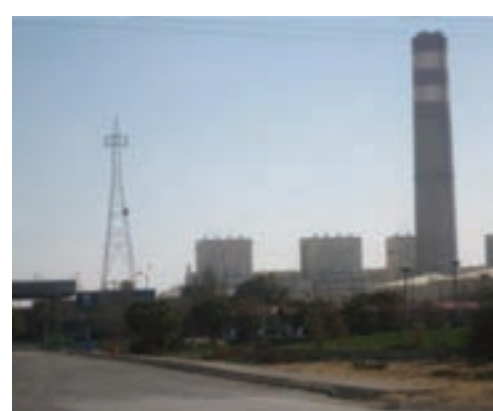
شکل ۱۹-۵- نیروگاه برق شهید مفتاح - فامنین
