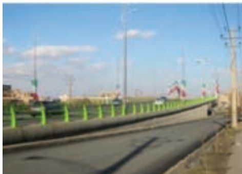
شکل ۱۰-۶- پل روگذر رسالت - همدان
