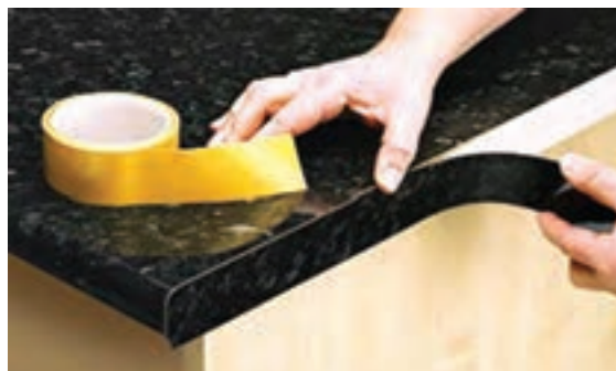
شکل ۱۱۹ - نصب نوار لبه صفحه تاپس
