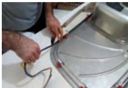
شکل ۱۰۴- نصب نوار آب بندی پشت لبه سینک
