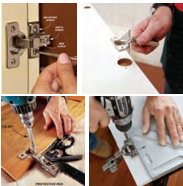
شکل ۴۹- نصب لولا روی در
