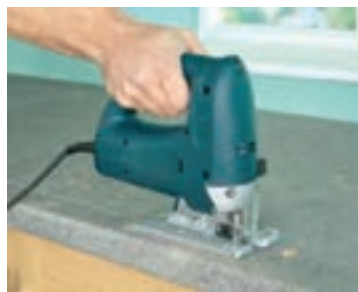
شکل ۱۰۱- برش کاری محل قرارگیری سینک
