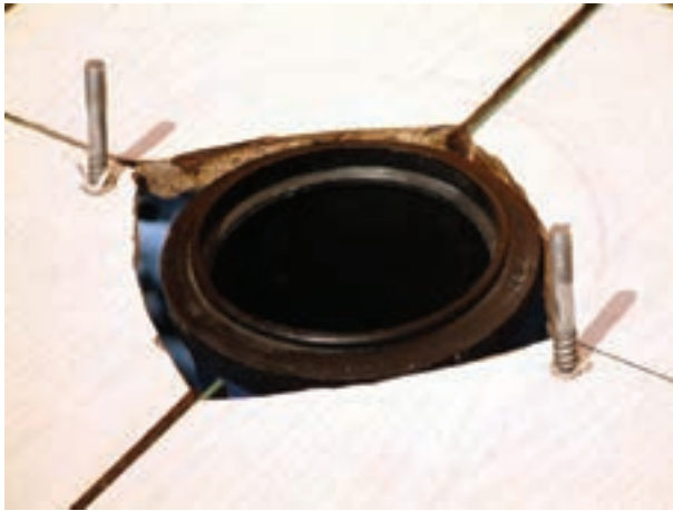
شکل ۲۴۷-۳- بستن پیچ های روکا در داخل رولپلاک ها
