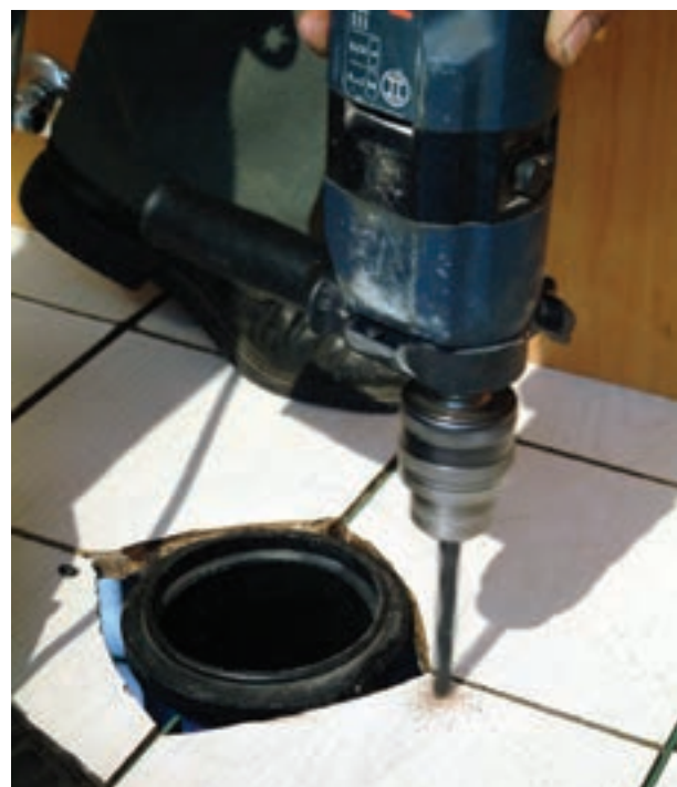
شکل ۲۴۶-۳- سوراخ‌کاری محل‌های علامت‌گذاری شده
